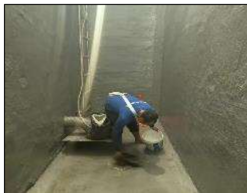
ภาพที่ 8 ล้างทำความสะอาดถังเก็บน้ำ
