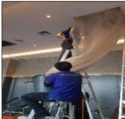
ภาพที่ 36 ล้างทำความสะอาดเครื่องปรับอากาศ
