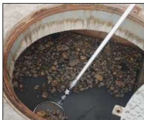
ภาพที่ 16 ตักไขมันและล้างถังดักไขมัน
