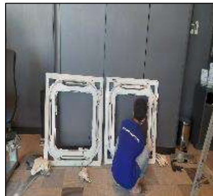
ภาพที่ 37 ล้างทำความสะอาดถาดรองรับน้ำเครื่องปรับอากาศ
