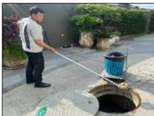
ภาพที่ 16 ตักไขมันและล้างถังดักไขมัน
