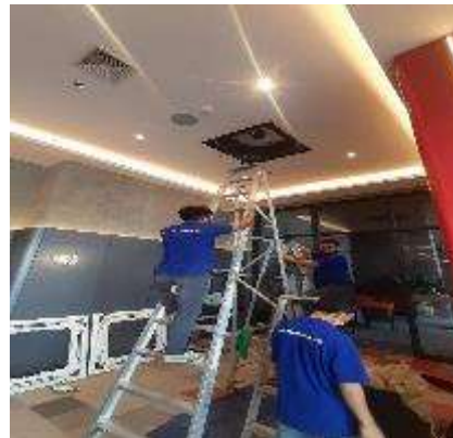
ภาพที่ 36 ล้างทำความสะอาดเครื่องปรับอากาศ
